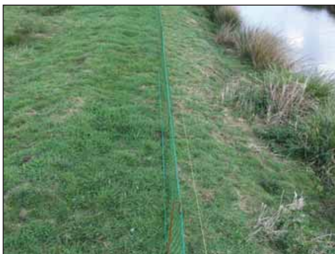
Figuur 4.8. Het raster met aan de kant van De Deelen schrikdraad. Foto: Sander Terlouw.
